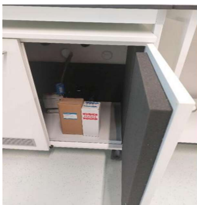
Figura 1 - Modelo de compartimento com isolamento acústico e exaustão apropriada para abrigar bombas de vácuo dos equipamentos de espectrometria de massas.
