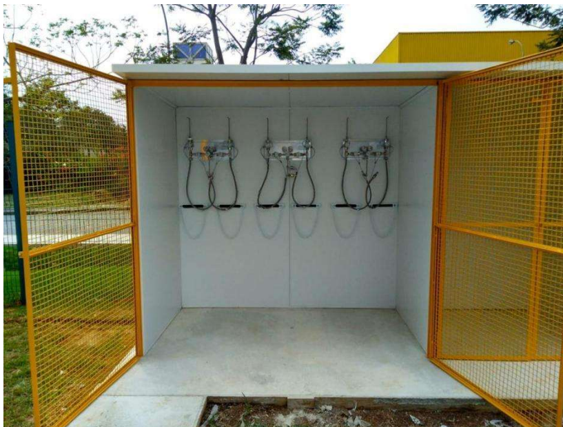
Figura 9 - Exemplo de Casa de Gases adequada.
