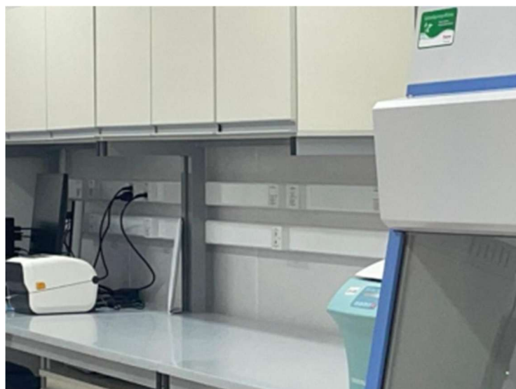
Figura 15 - Exemplo de fiação embutida em duto externo na horizontal.
