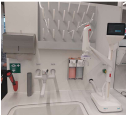
Figura 4 - Modelo de estação de área molhada para lavagem de vidrarias, mãos e lava-olhos de emergência, equipada com purificador de água de outro modelo.
