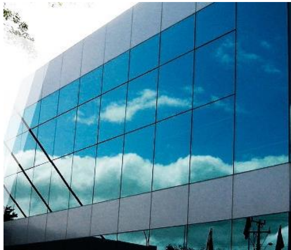
Fig. 89 - padrão de vidro e ACM de fachada
