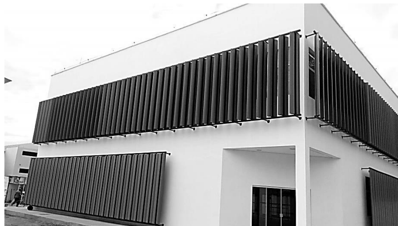
Fig. 97 – Padrão de brise de fachada
