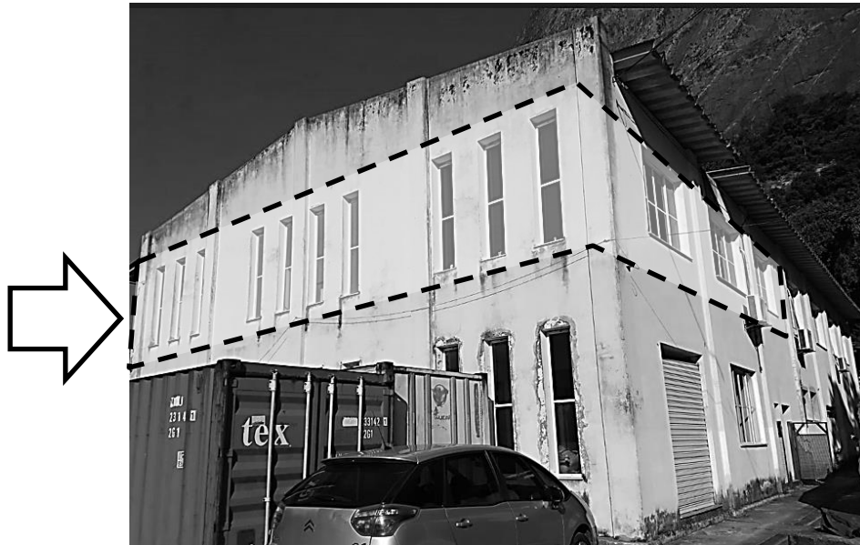
Fig. 81 - Janelas externas a serem modificadas
