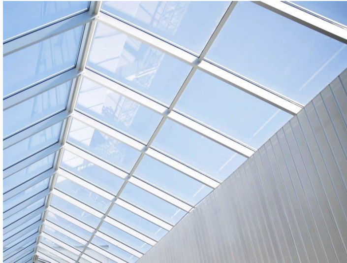
Fig. 73 - Cobertura de vidro laminado e estrutura de alumínio
