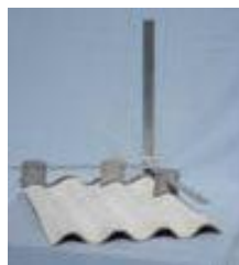
Fig. 150 - Modelo de suporte e terminal aéreo instalado na cobertura.
