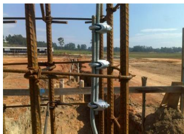
Fig. 152 - RE-BAR fixado dentro da estrutura
