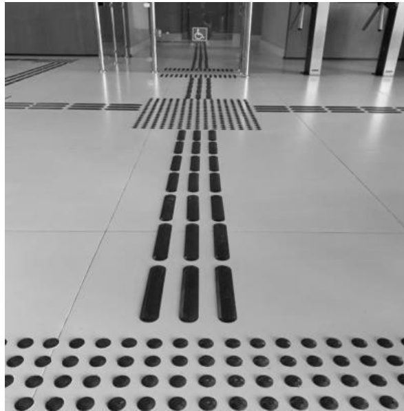
Fig. 98 – Sinalização e piso tátil horizontal / acesso ao elevador
