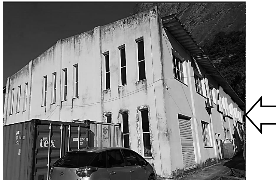
Fig. 83 - Janelas externas a serem modificadas (pintura e selamento)
