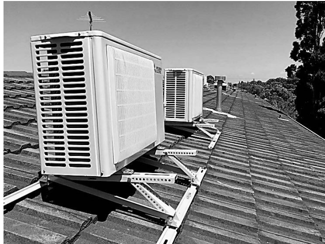
Fig. 95 – Instalação de unidades condensadoras na cobertura
